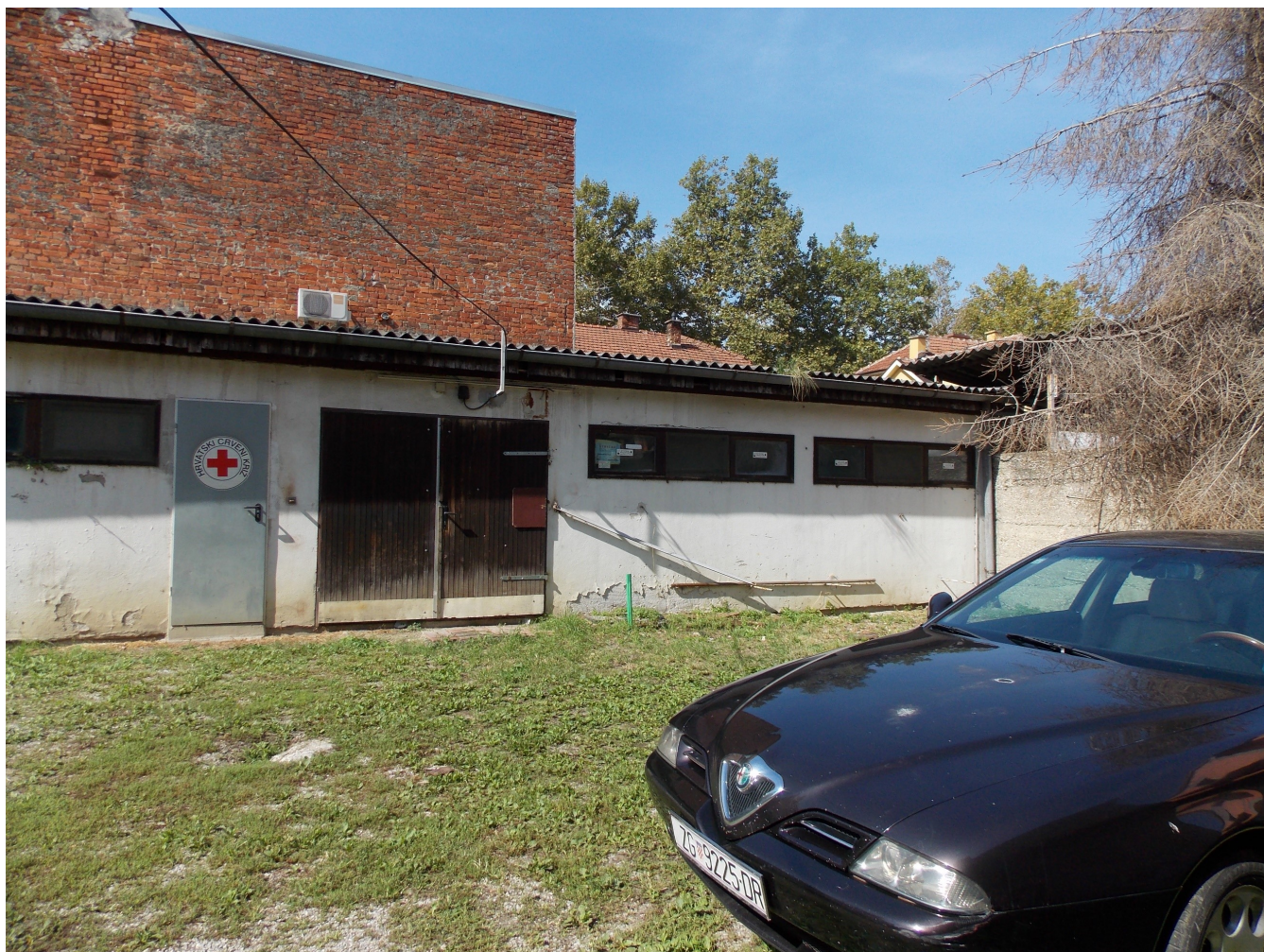
POSTOJEĆE STANJE – DVORIŠNI OBJEKT – POGLED ISTOK
