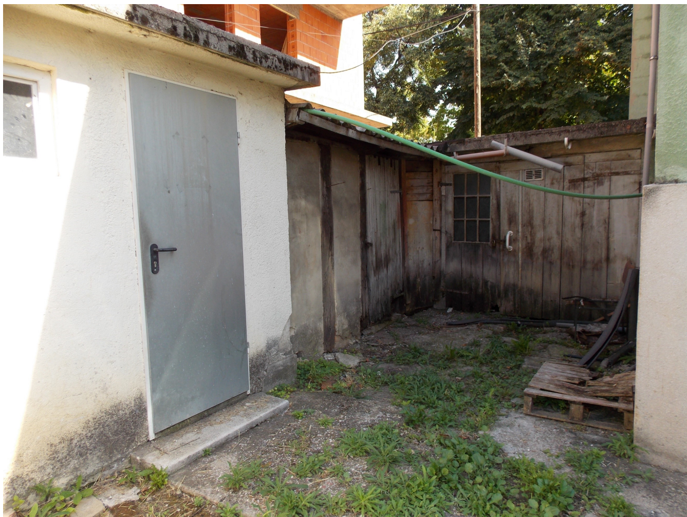
POSTOJEĆE STANJE – DVORIŠNI OBJEKT - POGLED ISTOK
