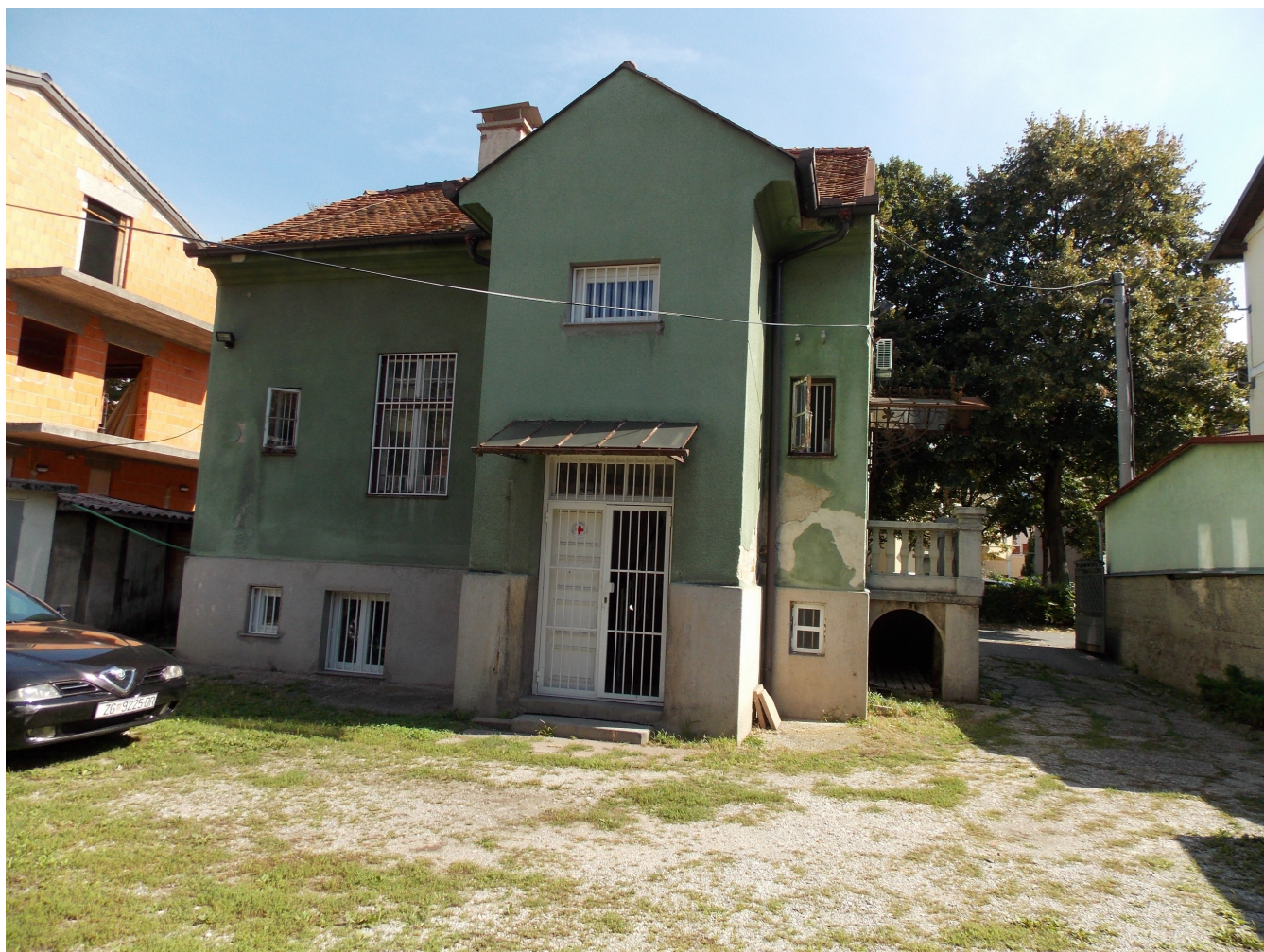
POSTOJEĆE STANJE - POGLED ZAPAD
